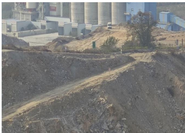
照片 1-6 矿区道路
