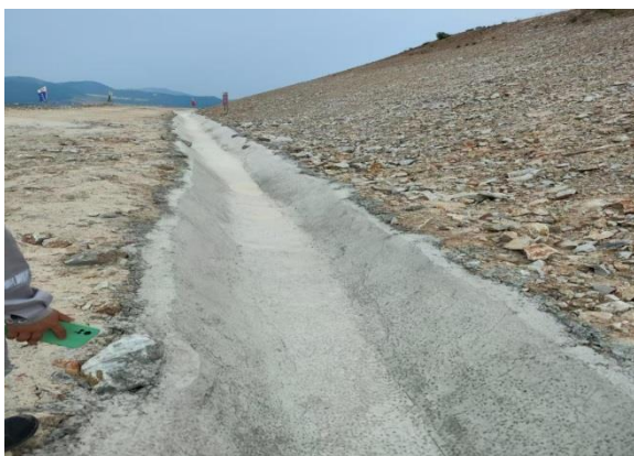
照片 2-8 修建排水渠
