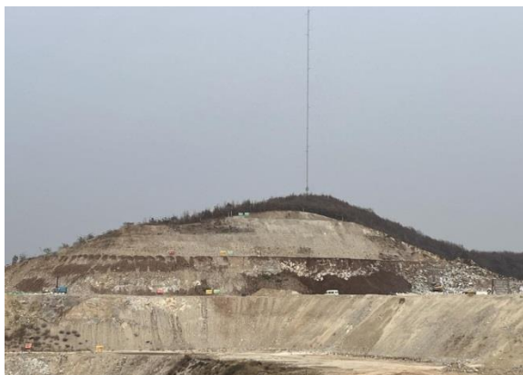
照片 2-6 终了平台治理
