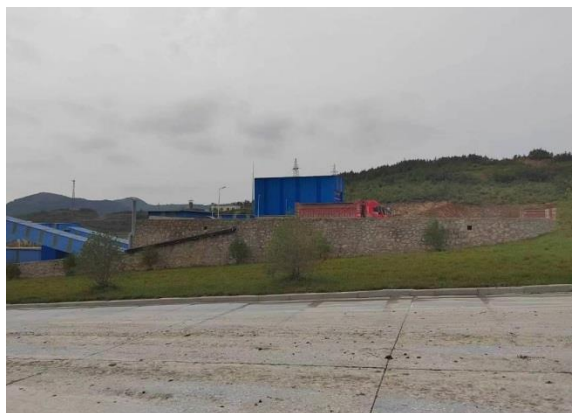
照片 2-7 矿区道路硬化
